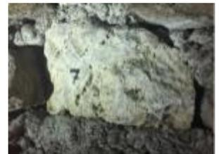
Nel complesso si è evidenziato la presenza di una elevata disomogeneità dei materiali da costruzione utilizzati nelle strutture, presumibilmente dovuta a diverse destinazioni d'uso che si sono succedute nel tempo.
